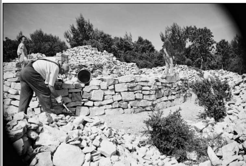
Vue arrière de la capitelle en reconstruction
