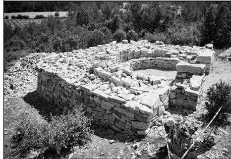
“ ...une maçonnerie en pierre sèche est comme un jeu de patience en volume, un puzzle dans l'espace. Elle requiert un choix et un positionnement judicieux du matériau, un ajustage minutieux et un emboîtement précis des éléments. Le maçon à pierre sèche doit avoir un bon coup d'œil pour trouver une place à chaque pierre et une pierre pour chaque place... ” Christian LASSURE (centre d'étude et de recherche sur l'architecture vernaculaire).
