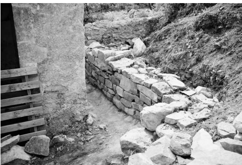
Mur de soutènement du Mazet en reconstruction
