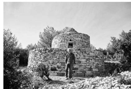
Partie Nord restauration terminée
