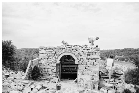
Finition de la partie haute
