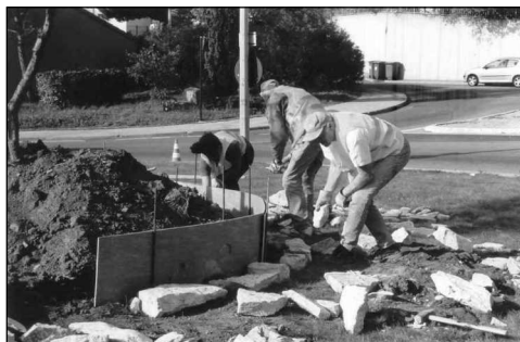
Mise en place de la première rangée.
