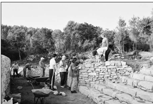
Restauration d'un mur bordant l'escalier
