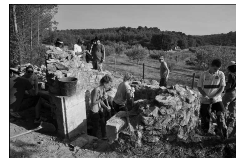
Chantier jeune sur les ruines
