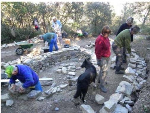
Nous avons réalisé les joints et rempli le bassin de pierres et de sable pour ramener sa profondeur à 80 cm (sécurité oblige).
